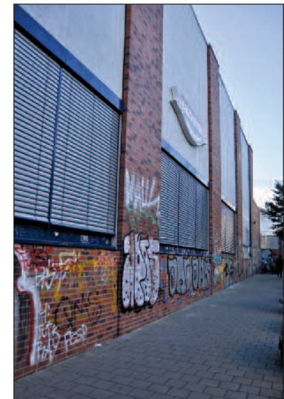
Magdalena Vollmer (Foto Mitte) verwandelte die nüchterne Salzbrenner-Fassade in ein Kunstwerk, das inzwischen zum großen Teil von Pflanzen überdeckt wurde
