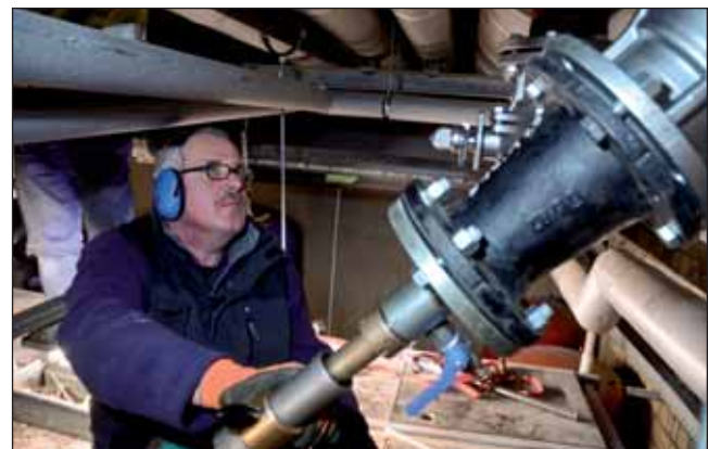
Bei laufendem Betrieb wird die neue Kühlanlage an das vorhandene Rohrsystem angebunden
